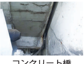
コンクリート橋桁端部の状況
