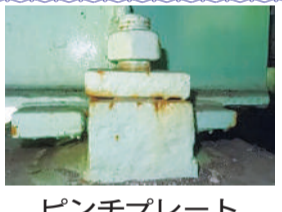
ピンチプレート付近からの防食
